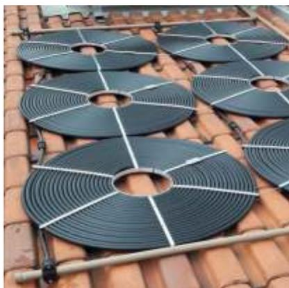
A instalação das placas podem ser feitas de varias maneiras , podem ser feitas com linhas de 2 ou 3 placas com uma bomba auxiliar que é o **RECOMENDADO** para quem não tem a possibilidade de instalar a bomba auxiliar tem a opção de instalar com a própria bomba do filtro, isto se for poucas placas. (Imagens na próxima pagina)
